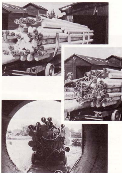
Figura 13. Vista do Processo Gewecke em execução.
